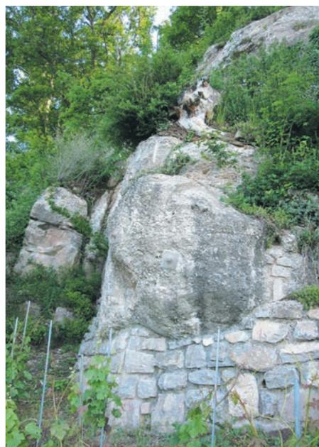
Consolidation par cloutage et mur de soutènement (Lavaux) date inconnue
